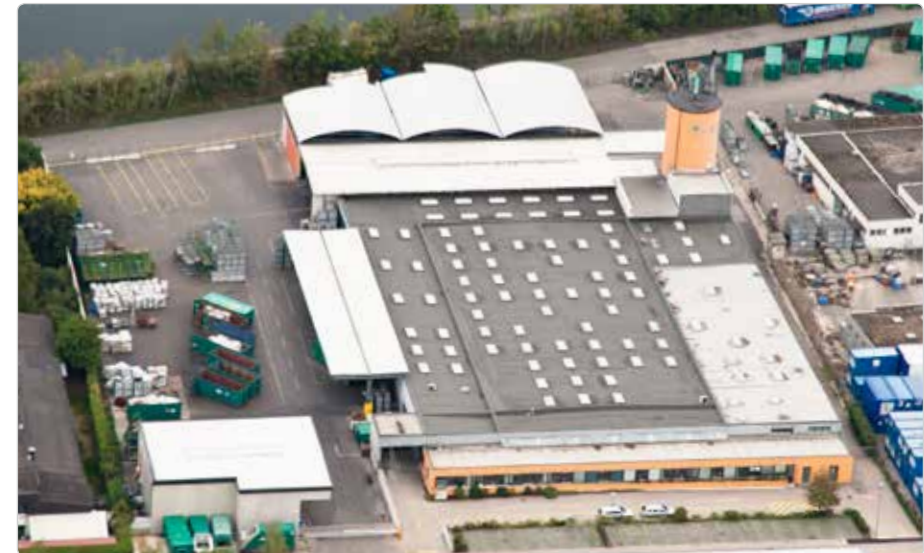
Abfall-Logistikzentrum in Wels
