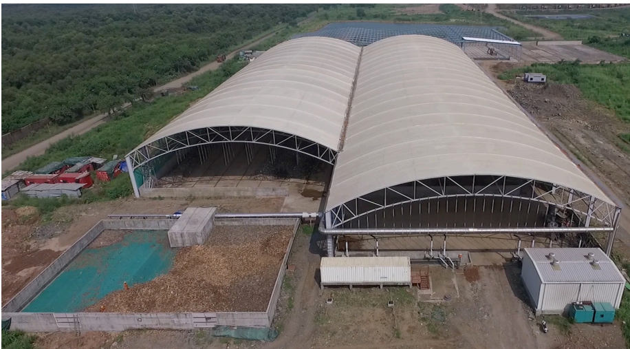
Abfallbehandlungsanlage in Kanjur
