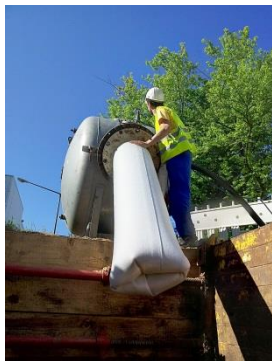
Aktiver Umweltschutz durch grabenlose Rohrsanierung
