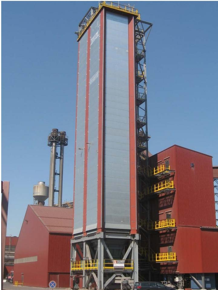
Multigon-Silozellen mit je 800m<sup>3</sup> Nutzinhalt für Ersatzbrennstoffe (EBS)
