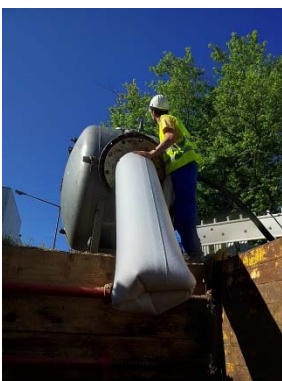
Grabenlose Rohrsanierung mit dem CIPP Schlaulingverfahren
