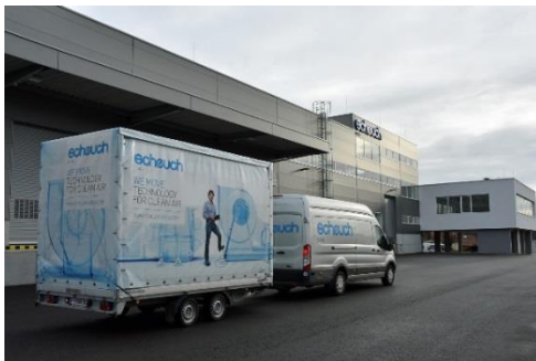
Ein Hänger vor dem neuen Gebäude der Scheuch LIGNO GmbH.
