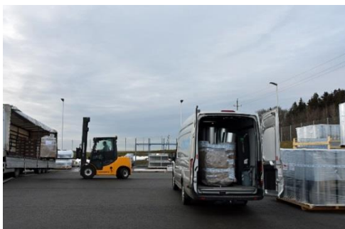
Das Rückmaterial wird von der Baustelle mitgenommen.
