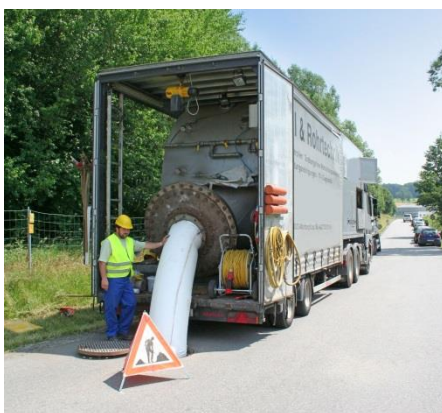
Grabenlose Rohrsanierung mit dem CIPP Schlauliningverfahren
