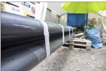
Das Verformen von über 600 m langen Rohrsträngen Vorort ist auch für RTi Neuland. AGRU stellte eine werkseigene Verformeinheit inklusive zweier Raupenabzüge zur Verfügung.
