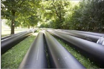
Mittels Heizelementstumpfschweißung fertigt RTi aus den von AGRU gelieferten Close-Fit Linerrohren (da 400 mm, SDR 26) Stränge zwischen 440 m und 624 m Länge.
