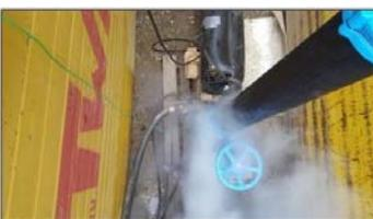
Zum Rückverformen wird der Close-Fit Liner mit Wasserdampf unter Druck gesetzt. Dank des Memory-Effekts springt er in seine ursprüngliche, kreisrunde Form zurück.
