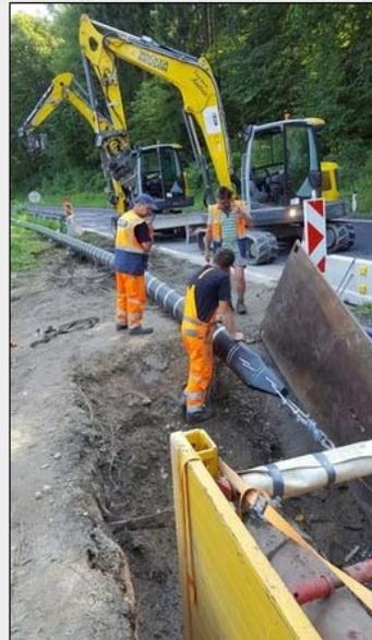
Der mit einem Ziehkopf ausgestattete Rohrstrang wird mittels Seilwinde ins Altrohr eingezogen.
