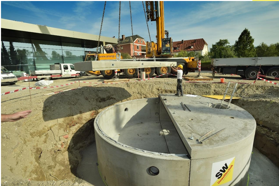
Bild 1+2: Aschach a. d. D. Versetzen des Regenrückhaltebehälters des Typ AQUAstore
